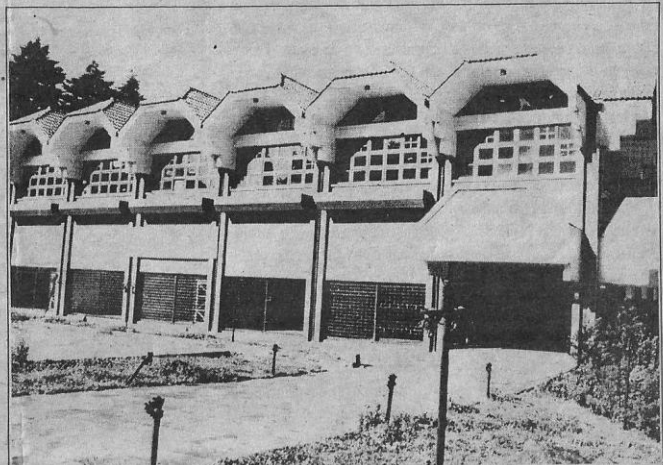
Prédio do Shopping Bela Vista: alvo de Gramado
